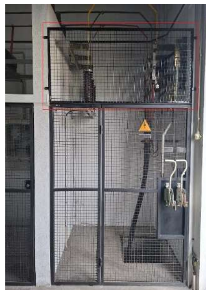
Figura 29 – Posto de Transformação
