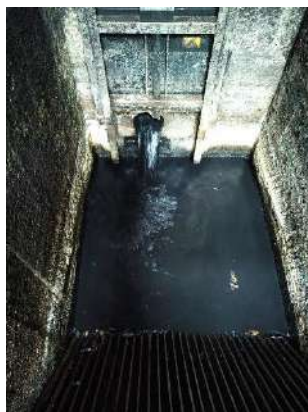
Figura 22 - Verificação de descarga não autorizadas na rede saneamento
