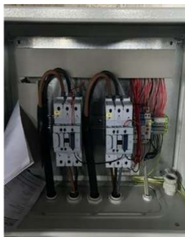
Figura 39- Contactores de isolamento
