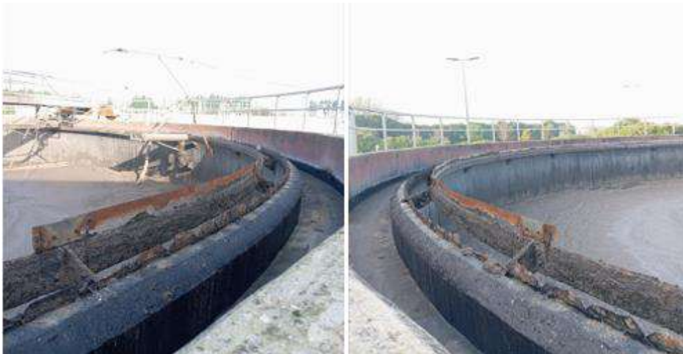
Figura 46 – Estado do Decantador antes da intervenção
