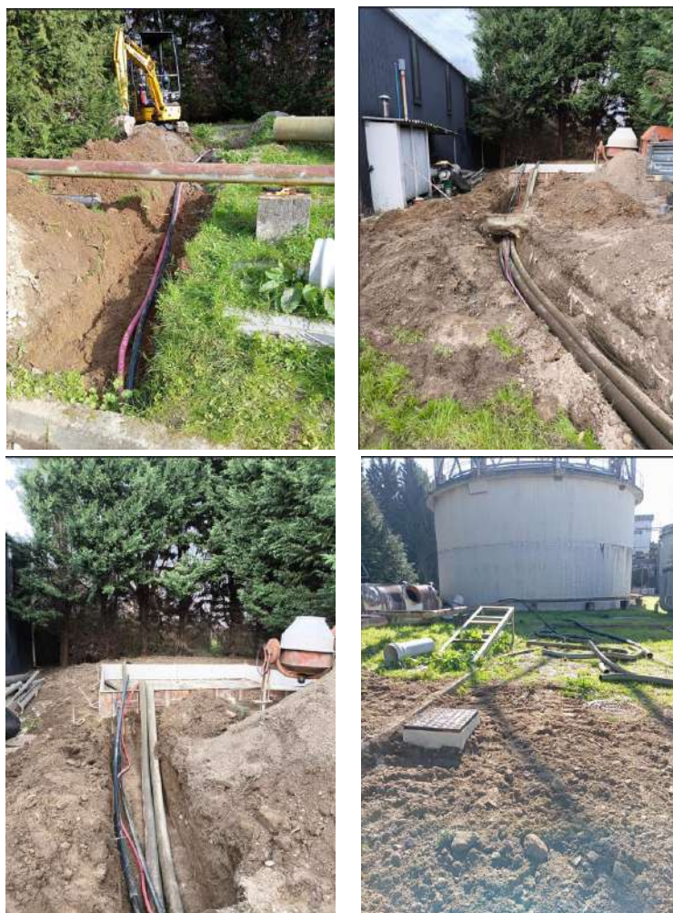
Figura 50 – Criação de ligações hidráulicas
