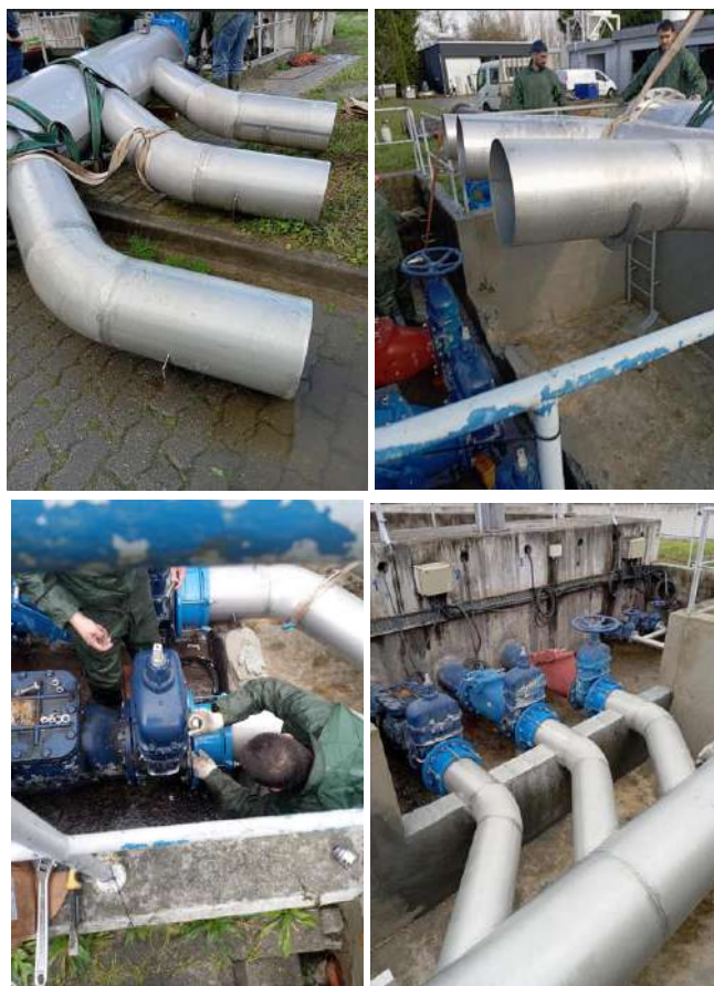
Figura 45 – Nova tubagem em aço inox
