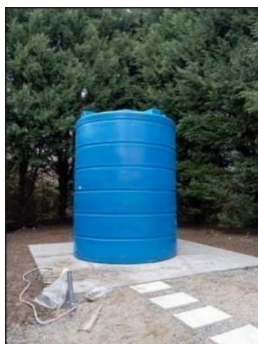
Figura 51 – Colocação de um reservatório em fibra
