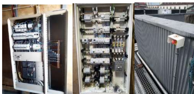
Figura 59 - Substituição de quadro elétrico
