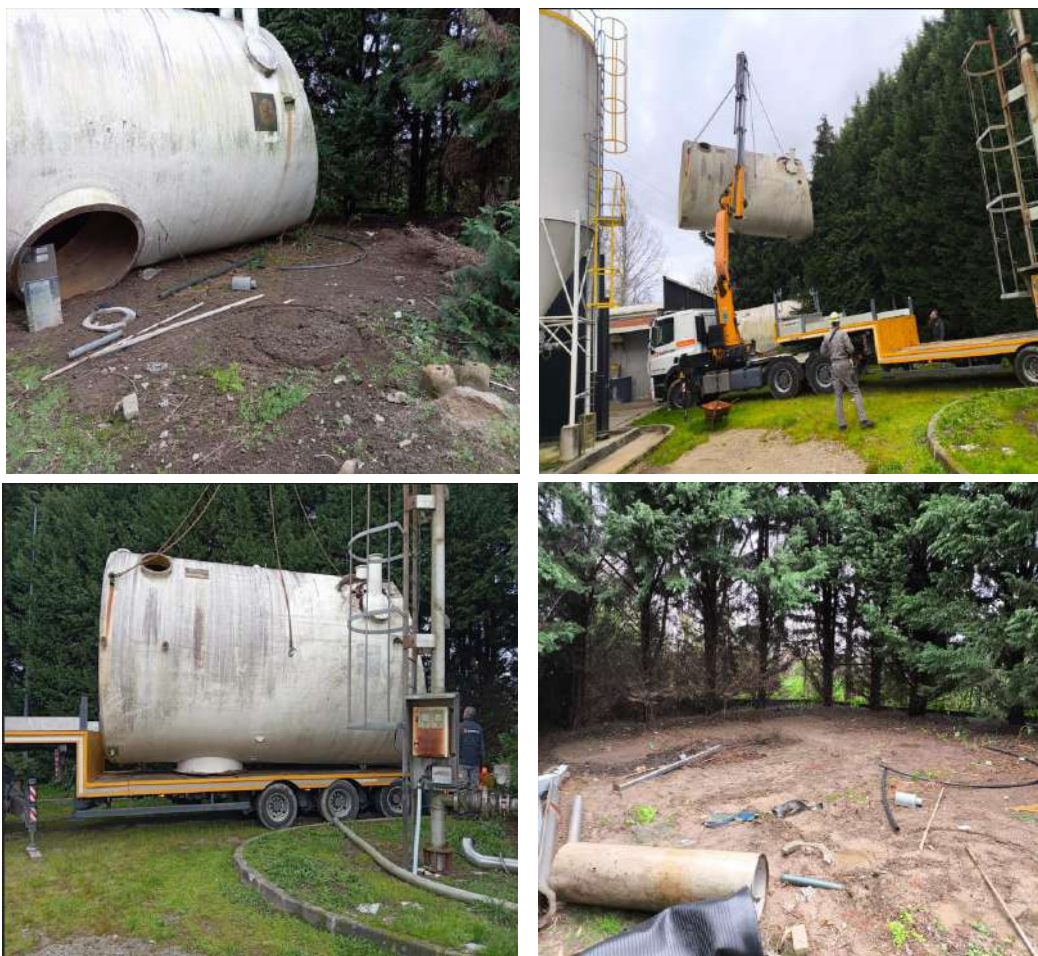
Figura 48 – Remoção dos antigos silos
