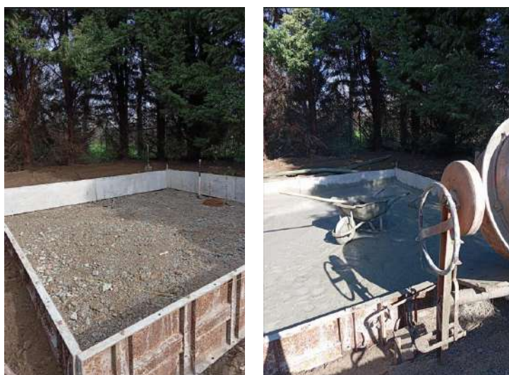
Figura 49 – Execução de base para novo reservatório
