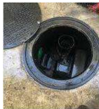
Figura 25 - Separador de gorduras após limpeza
