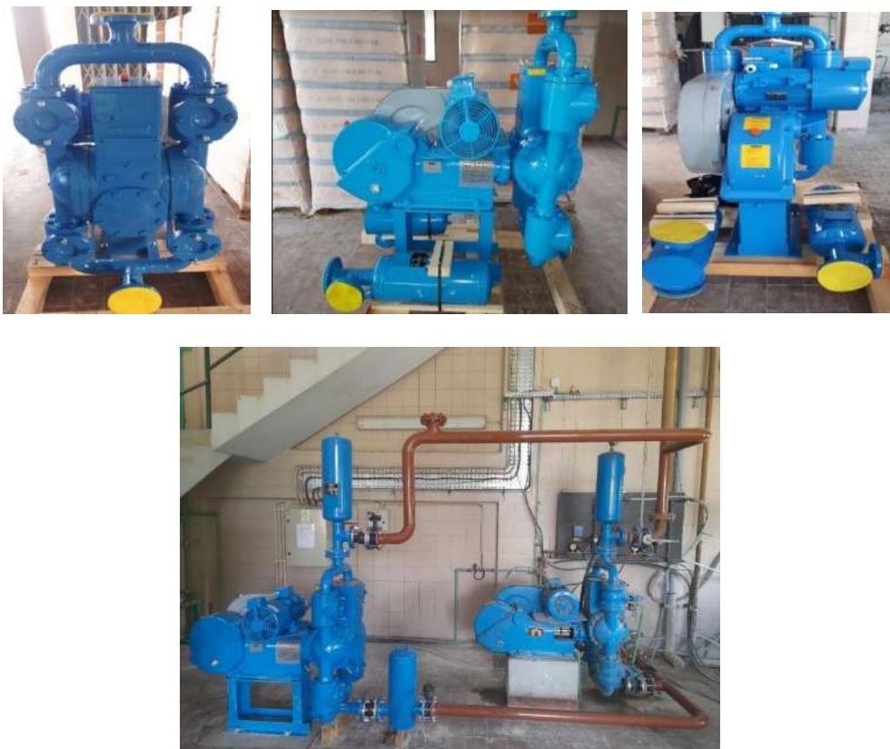
Figura 35- Filtro Prensa com nova bomba
